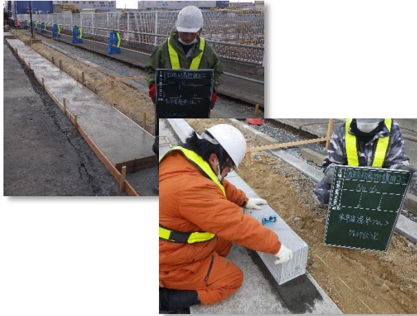
道路構造物(歩車道境界ブロック)復旧状況
