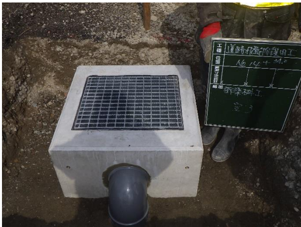
道路構造物(街渠柵)復旧状況
