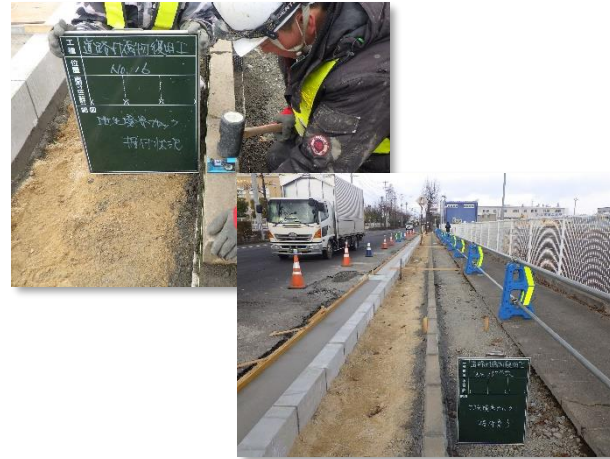
道路構造物(地先境界ブロック等)復旧状況
