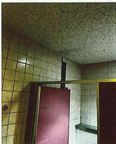
↑トイレタイル(内部)
