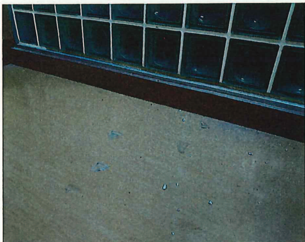
西側3階と屋上間の踊り場
