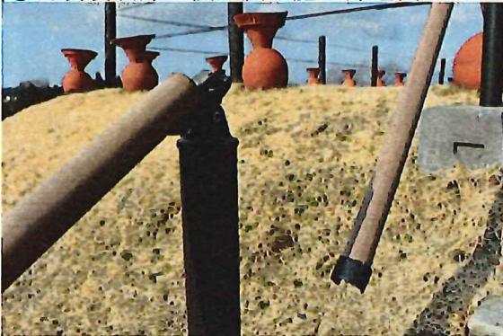
②園路階段の手すり(1箇所)が破損
