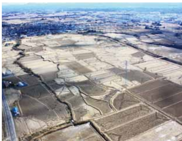
ほ場整備事業施工前
