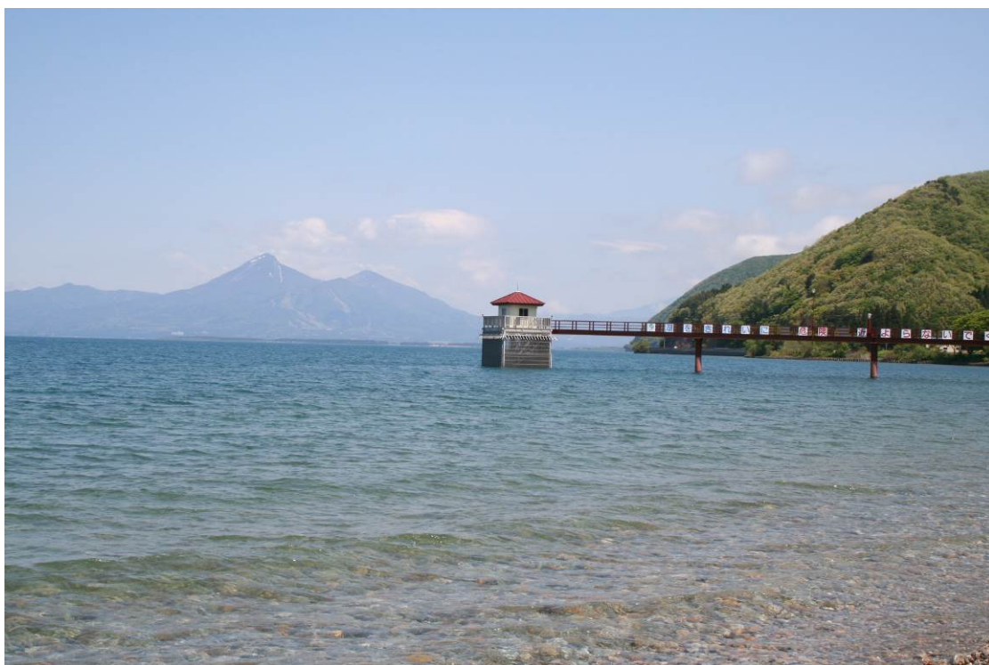
猪苗代湖と浜路取水塔
