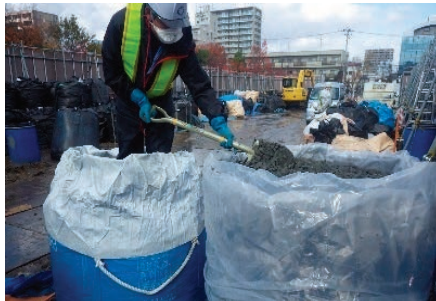
搬出作業の様子
