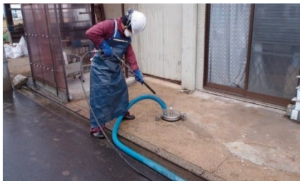
除染作業の様子
