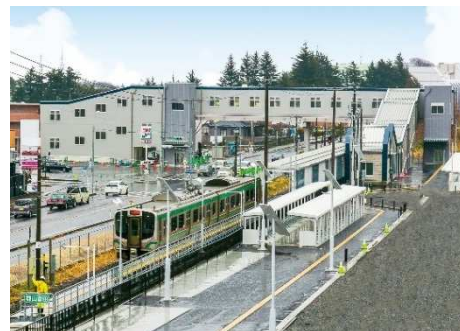
エレベータ設置など UDに配慮された郡山富田駅
