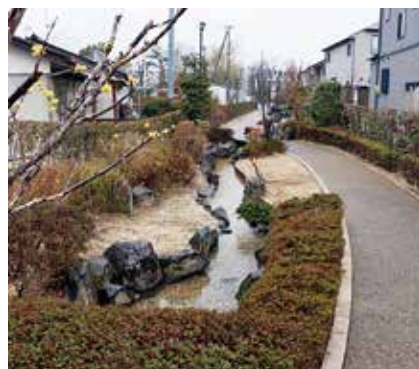
雨水排水路を利用した「せせらぎこみち」
