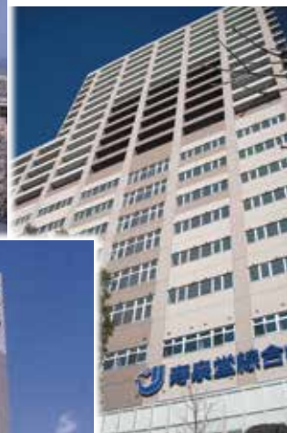
駅前一丁目地区 (再開発ビル)
