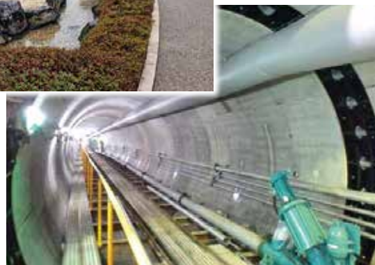
雨水貯留施設の整備「図景貯留管」
