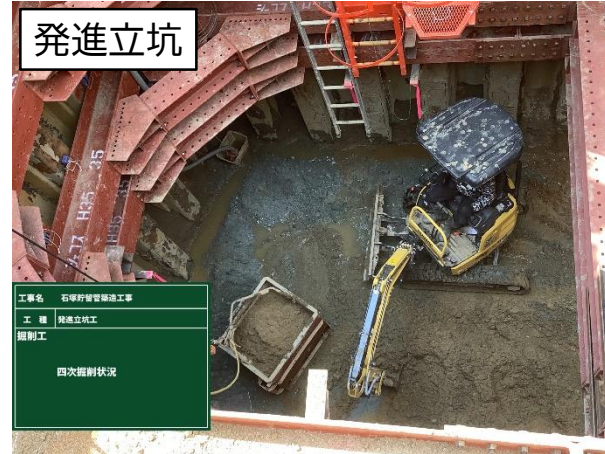
掘削・支保状況
