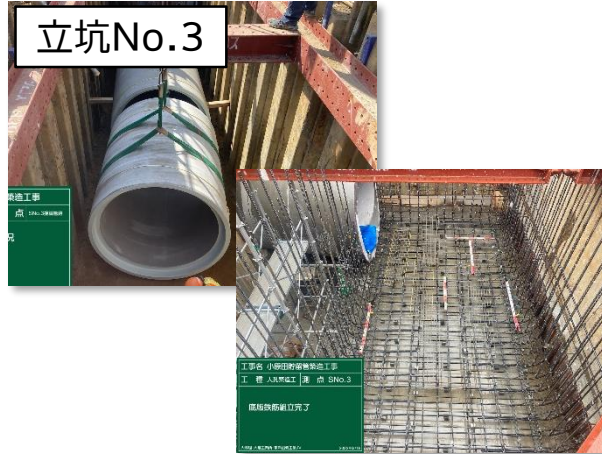
ヒューム管布設・特殊人孔底版コンクリート(配筋)状況
