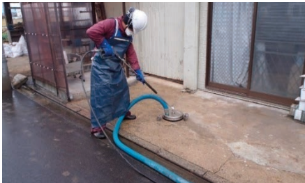
除染作業の様子
