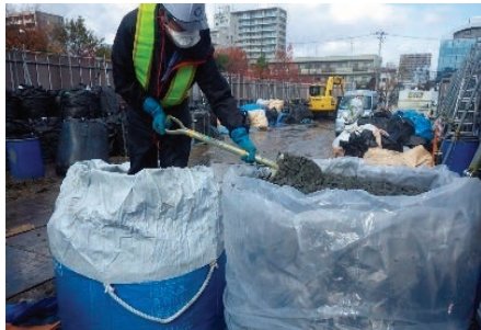
搬出作業の様子
