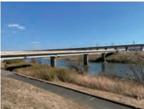
阿武隈川に架かる永徳橋
