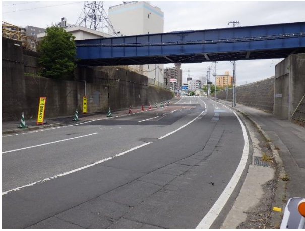
覆工板設置状況
