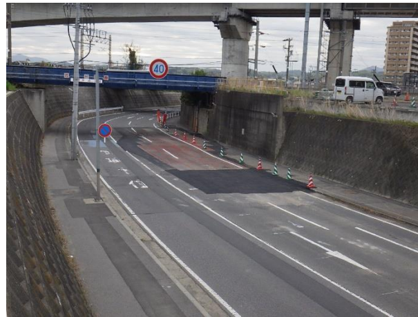
覆工板設置状況
