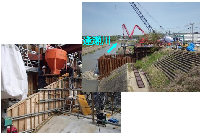
翼壁設置状況
