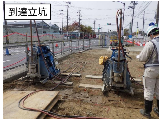
地盤改良工 (薬液注入状況)
