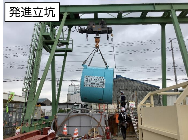
掘進機立坑吊り下ろし状況
