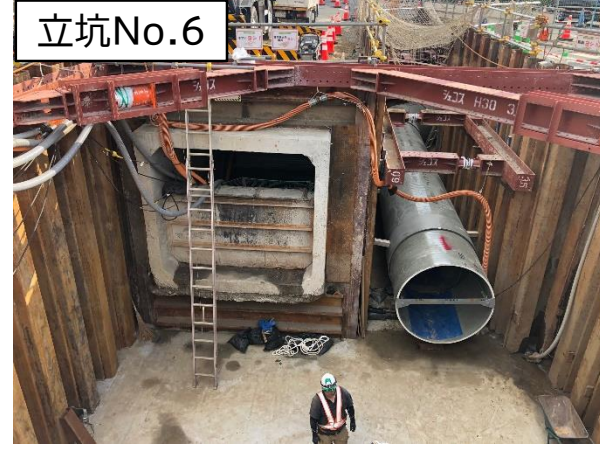
既設水路接続管路布設完了
