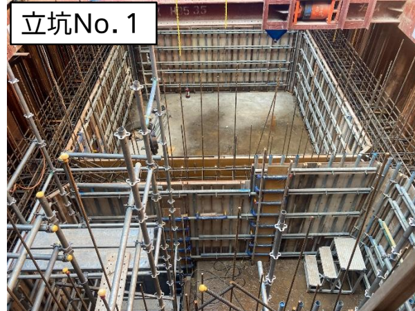
特殊人孔配筋・型枠組立
