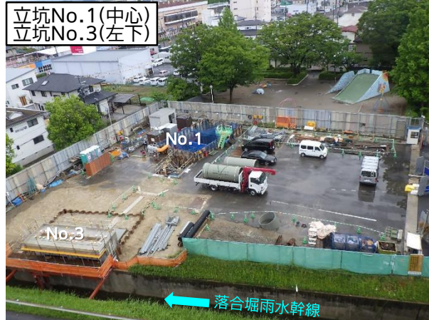
特殊人孔施工状況全景(池田公園内)
