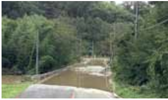
東日本台風で浸水により寸断した県道二本松金屋線金沢橋
