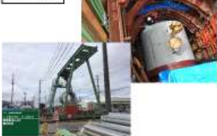
ヒューム管設置状況
