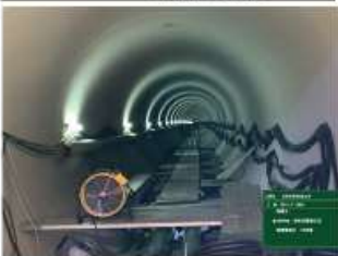
ヒューム管内部の状況
