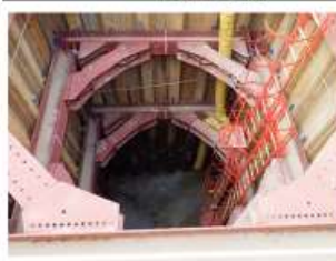
到達立坑完成
