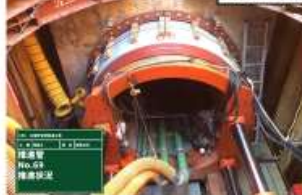
ヒューム管推進状況
