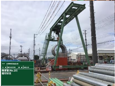
ヒューム管設置状況
