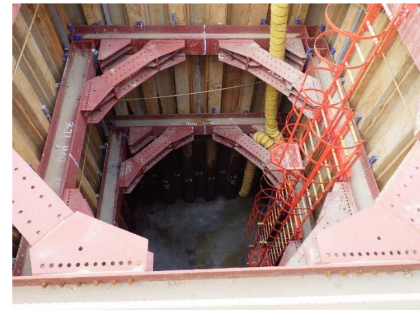
到達立坑完成
