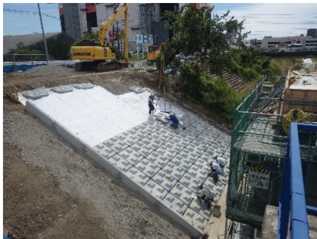
護岸工施工状況
