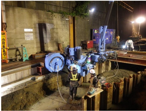
鋼矢板設置状況
