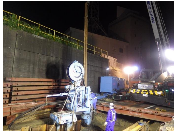
鋼矢板設置状況
