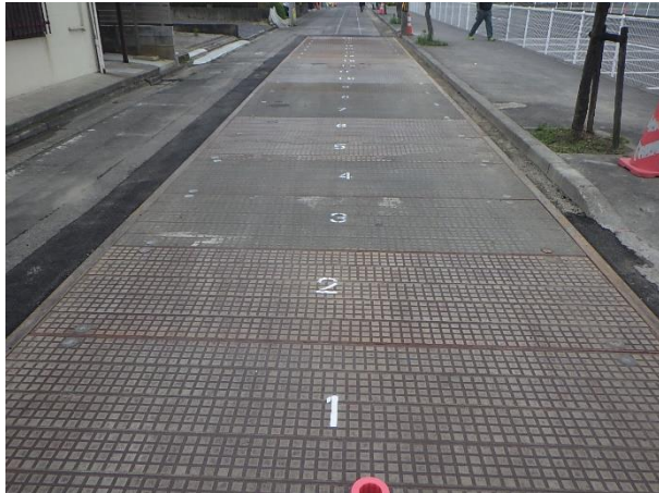
覆工板設置完了
