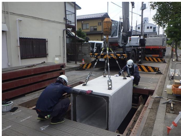
ボックスカルバート布設状況
