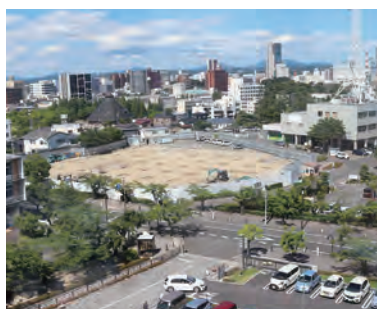
工事中の公文書館立体駐車場
