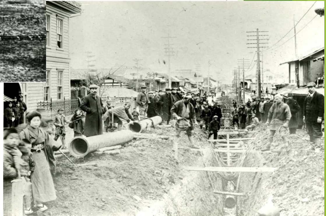
管路布設工事（現在のフロンティア通り）
