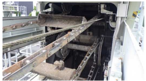
沈砂掻揚機 ⇒チェーン等駆動部の劣化
