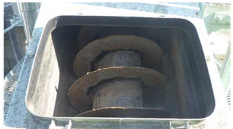
スクリュウコンベア ⇒羽根・ケーシングの摩耗
