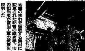
地震の揺れを吸収する構造で設置された配管の継ぎ手。市は地震発生後17日の緊急点検で確認した。
