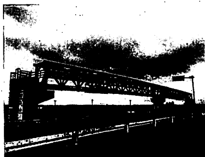
田村町大善寺にある水管橋
