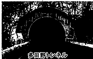
多田野トンネル
