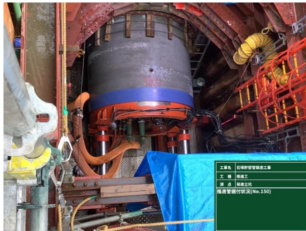
ヒューム管推進状況
