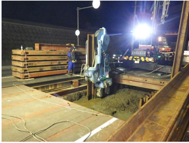
鋼矢板設置状況
