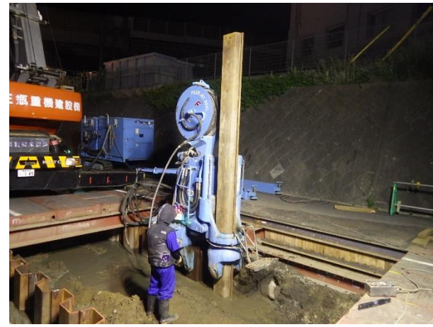
鋼矢板設置状況
