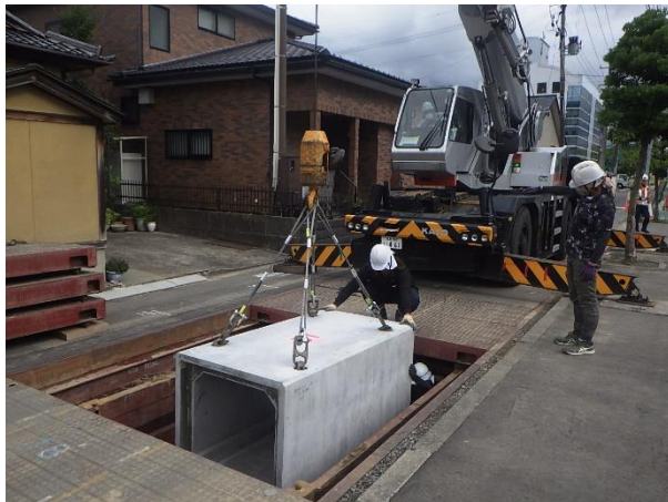
ボックスカルバート布設状況
