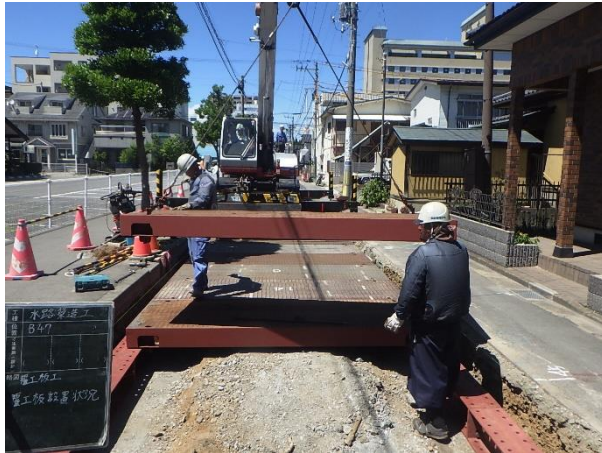
覆工板設置状況
