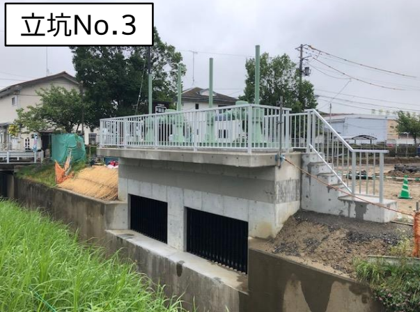
分水人孔ゲート設置完成
