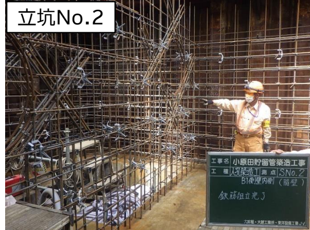
鉄筋組立完了
