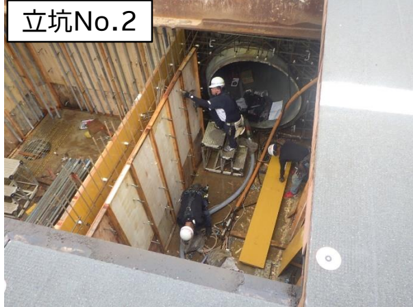
型枠設置状況
