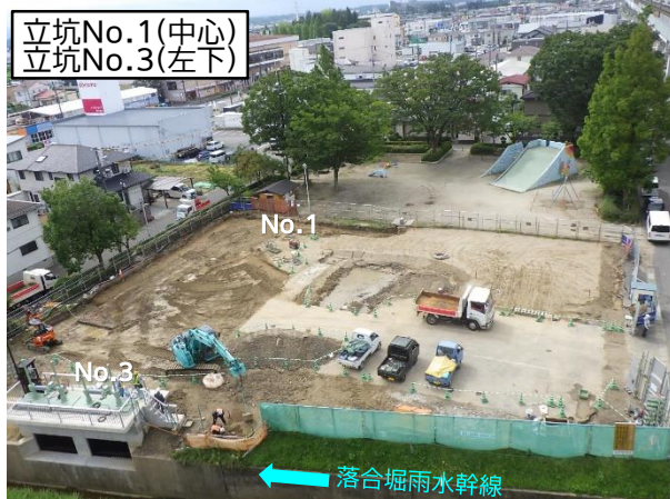
池田公園復旧状況(発進立坑部)
