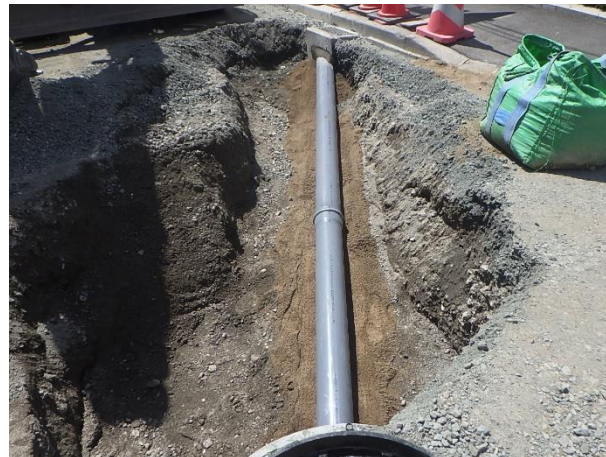
取付管接続設置
