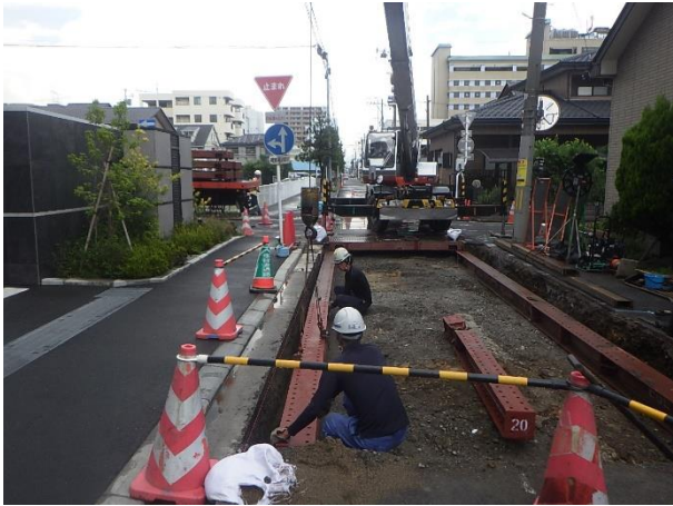
覆工板設置状況
