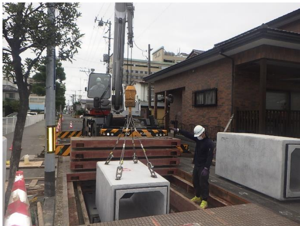
ボックスカルバート布設状況
