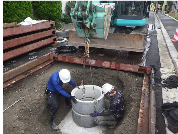
マンホール設置状況
