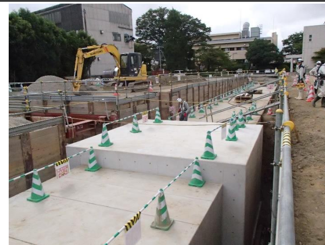
中継柵設置完了
