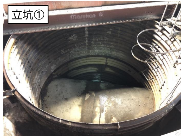
ライナープレート設置完了
