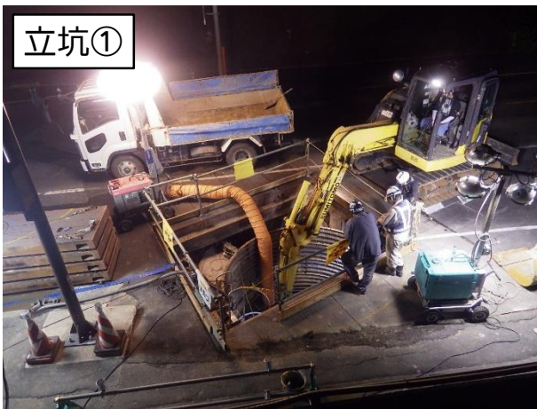
ライナープレート設置状況
