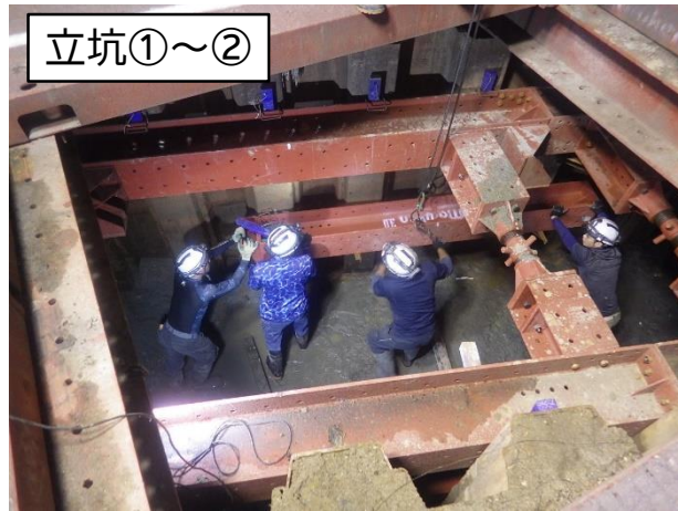
仮設材設置状況（土留工）
