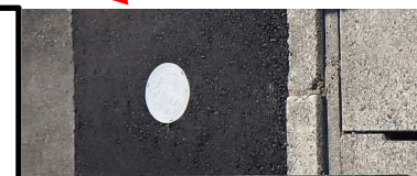
図：公共汚水ます 工事後の地表部分
