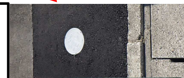
図：公共汚水ます 工事後の地表部分
