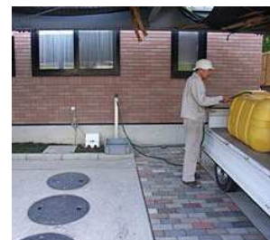
雨水貯留タンク
