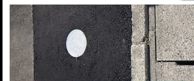
図：公共汚水ます 工事後の地表部分
