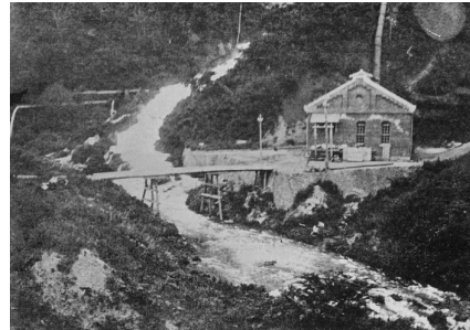
郡山発展の原動力となった沼上発電所
