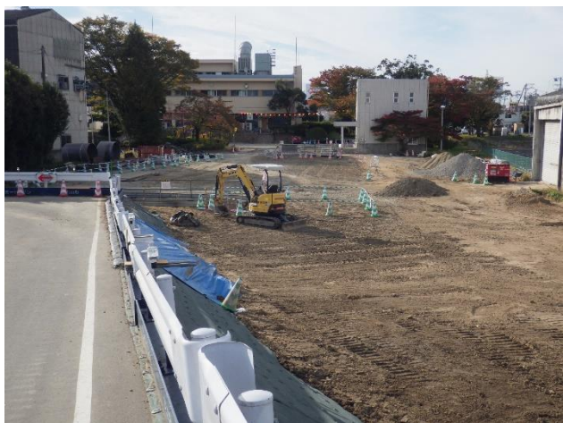
放流渠埋戻完了
