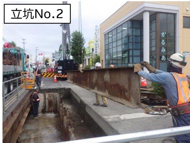
覆工板撤去状況
