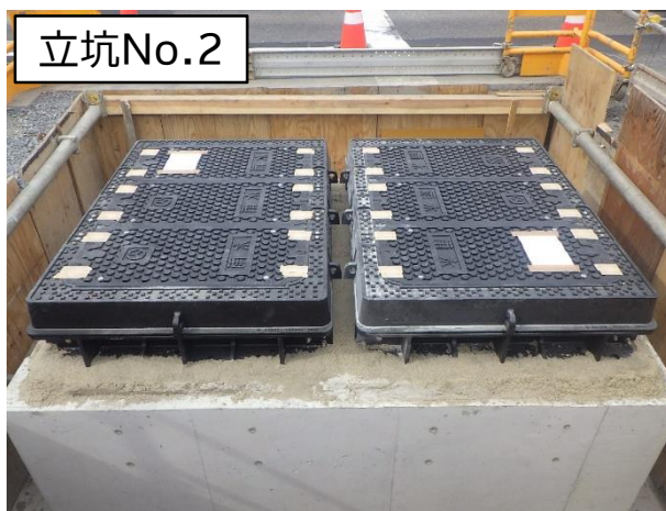
鉄蓋設置完了
