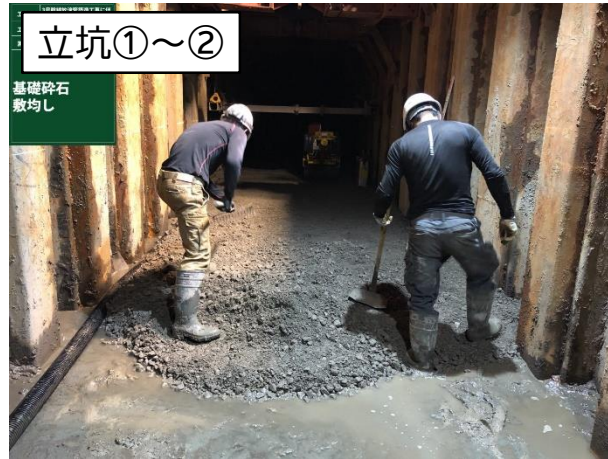
基礎碎石敷均し状況（函渠布設工）
