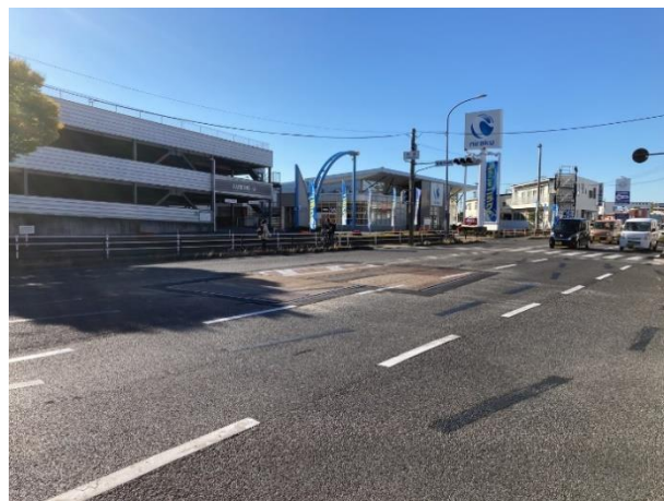
覆工板設置完了
