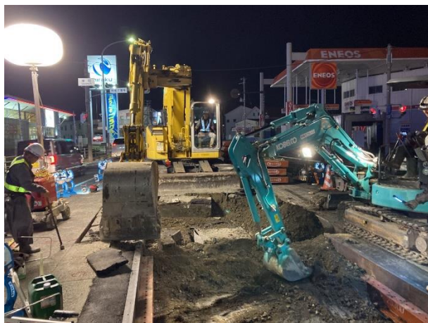
覆工板設置状況
