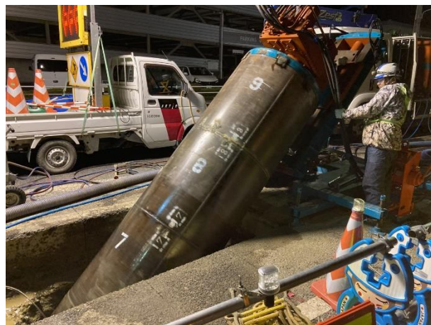
取付管推進状況
