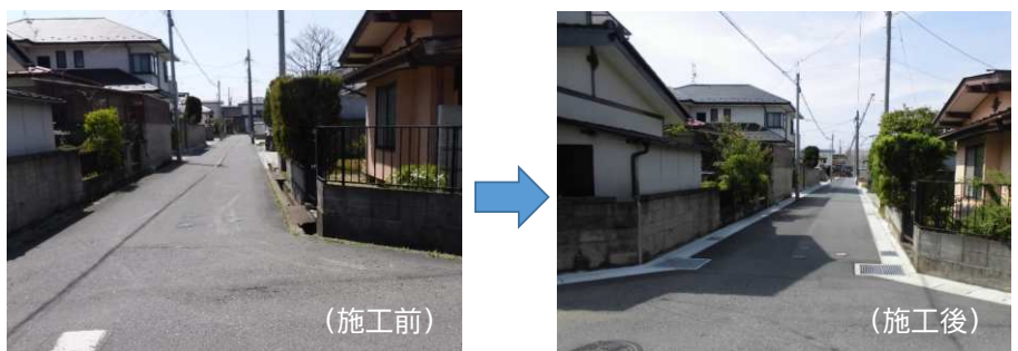
【水路側溝整備工事イメージ】
