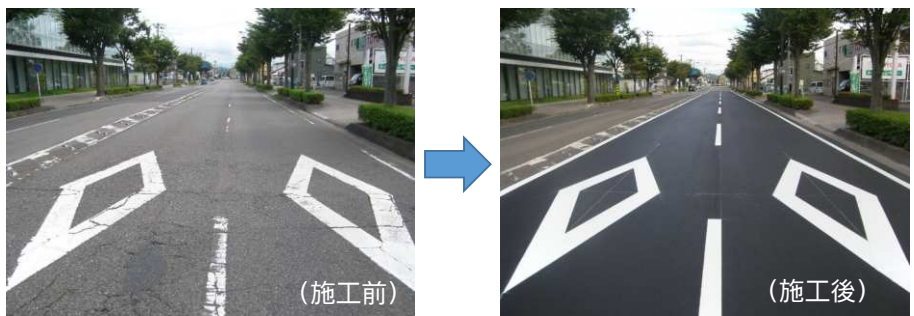
【道路維持補修工事イメージ】
