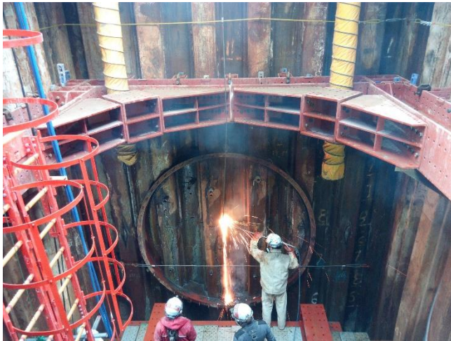
掘進機回収準備
