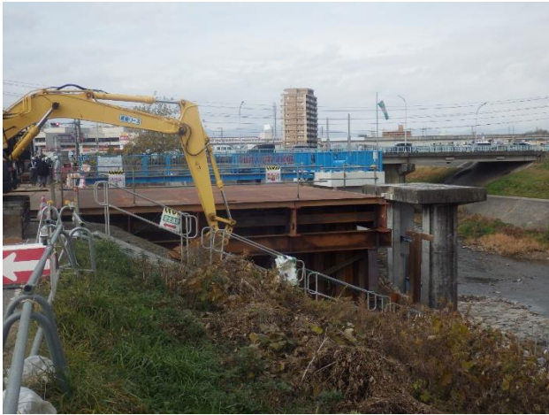
仮栈橋設置完了
