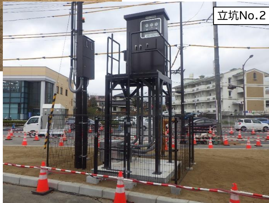
排水ポンプ制御盤 設置完了
