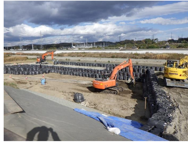
仮締切工（大型土のう設置）
