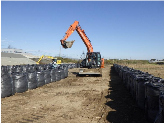
仮締切工（大型土のう設置）
