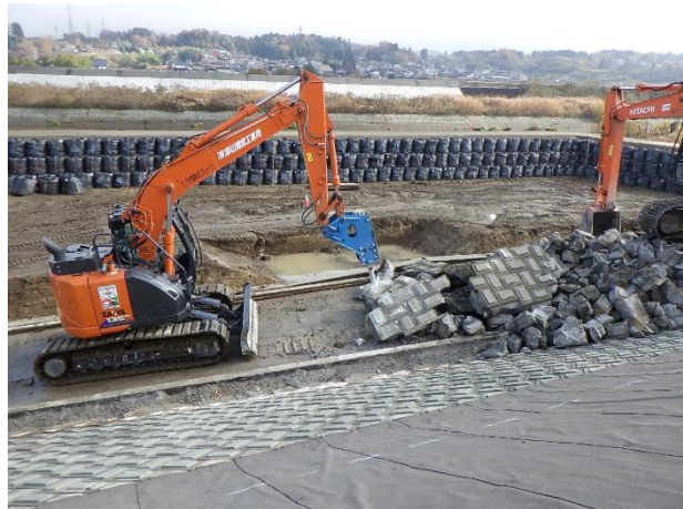
構造物撤去状況
