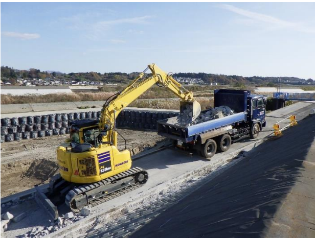
構造物撤去状況
