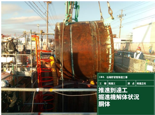
掘進機搬出状況
