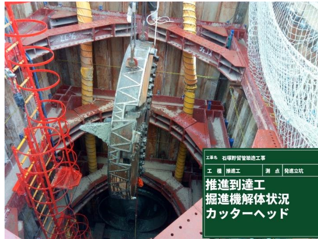
掘進機搬出状況
