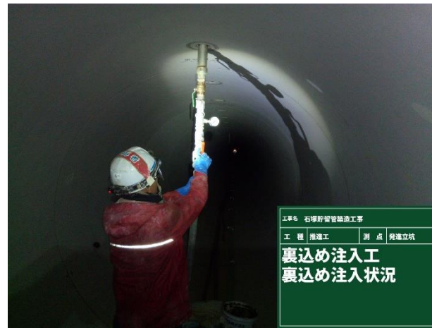
裏込め注入状況
