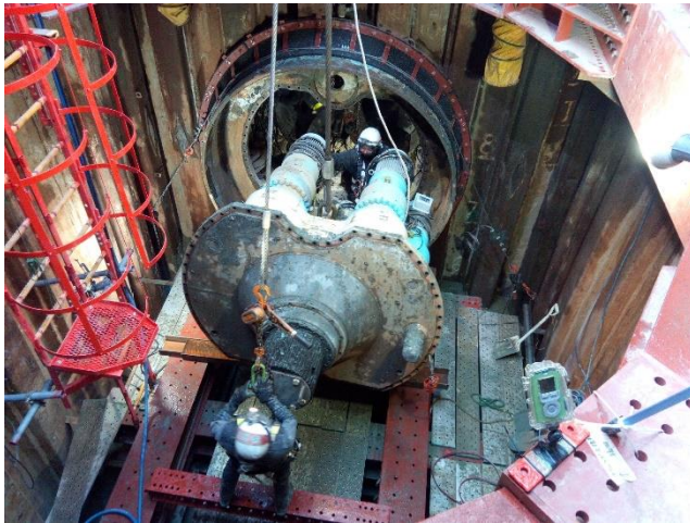
掘進機解体状況
