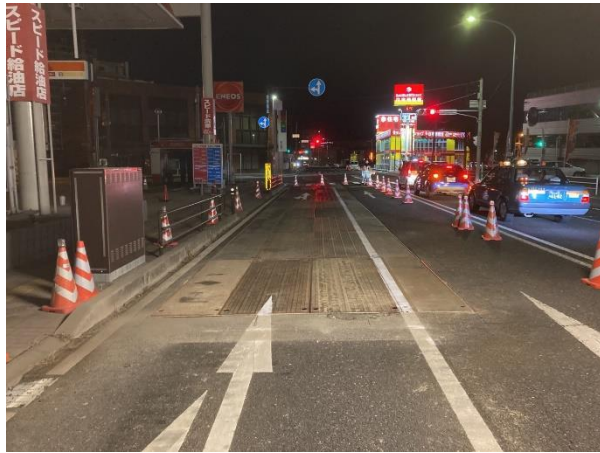
覆工板設置完了
