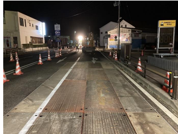
覆工板設置完了
