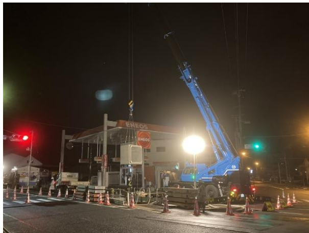
ボックスカルバート設置状況
