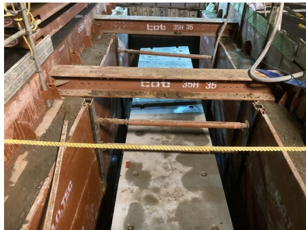
ボックスカルバート設置完了
